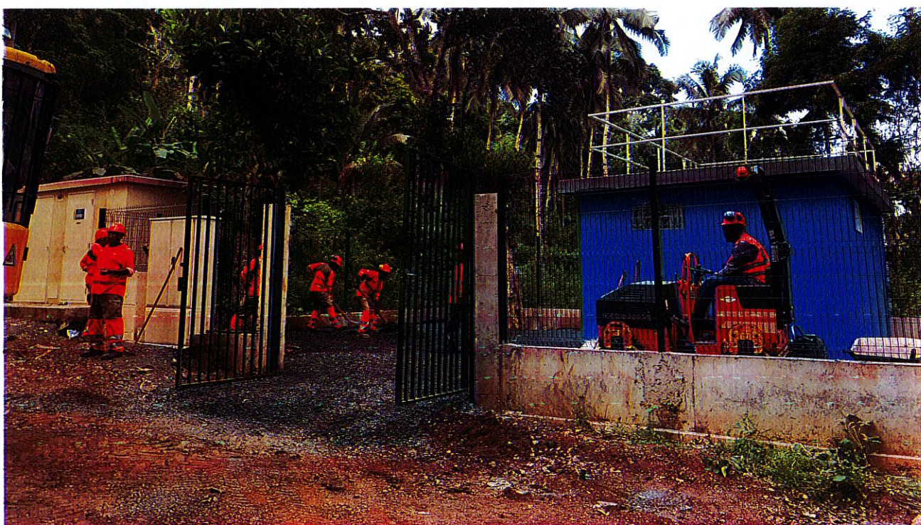
FIGURE 14 : PRISE DE VUE DE LA CLÔTURE ET VRD ASSOCIES AU PROJET (EGIS EAU, 2018)
