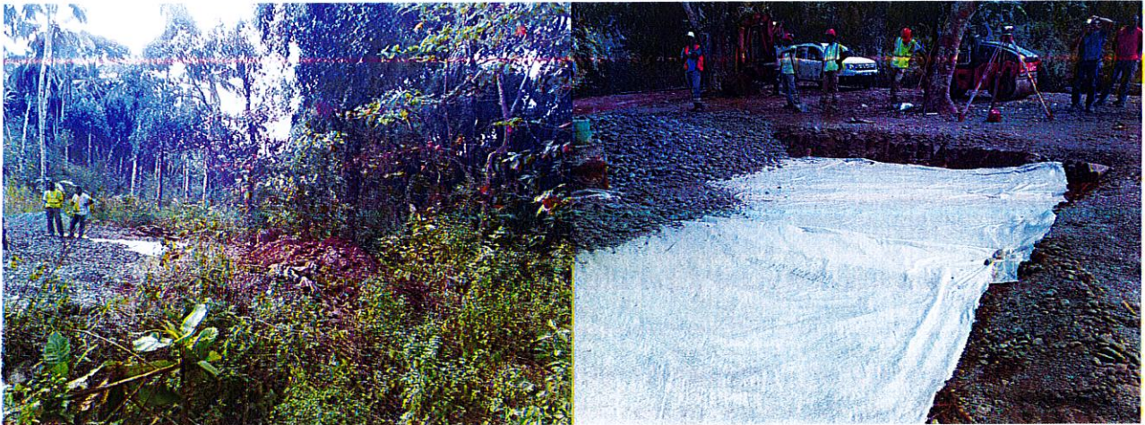
FIGURE 10 : PHOTOGRAPHIES DES OPERATIONS DE DEBROUSSAILLAGE ET TERRASSEMENT EN COURS (EGIS EAU, 2017)
